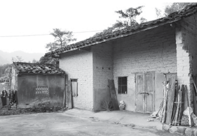
Hiện toàn thôn còn 7 nhà xây dựng theo kiến trúc cổ của người Tày nhưng đại đa số đã xuống cấp.
