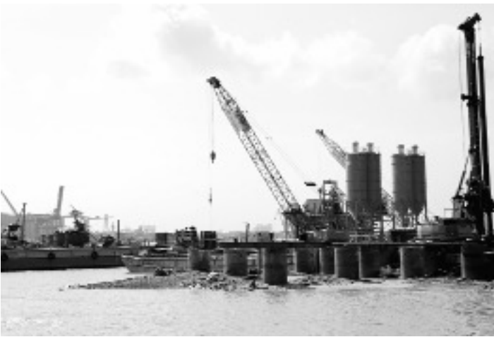
Gói thầu số 3, Dự án cầu Bạch Đằng do nhà thầu Cienco1 thi công.
